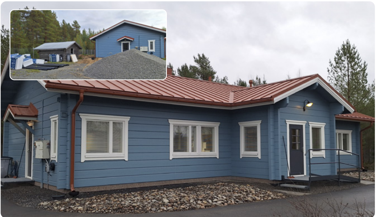
Jätekeskuksen toimiston perusparannusprojektiä jatkettiin uusimalla salaojitus ja sadevesien johtamisjärjestelmät. Samassa yhteydessä parannettiin tilojen esteettömyyttä uusilla portailla.
